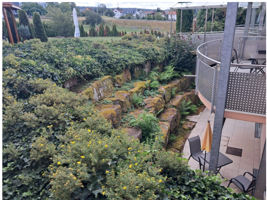
Foto 5: Treppenartige Hangabsicherung, Oberkante mit Gebüsch (Bioplan 2024)
