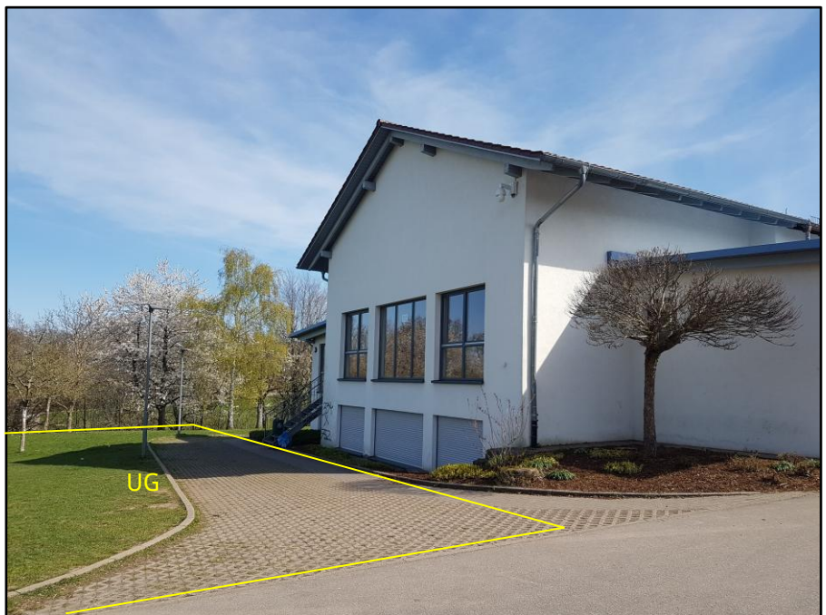
Foto 3: Blick nach Westen auf die direkt angrenzende Turnhalle.
